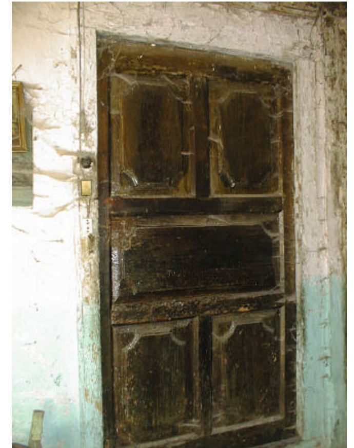
Puerta interior en planta baja.
