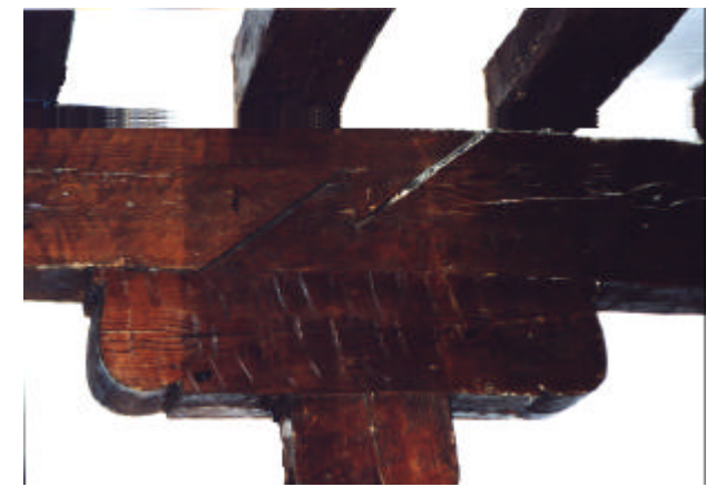
Unión vigas - pilar
